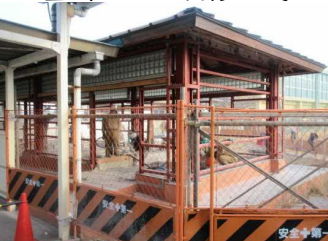
▼ 屋外トイレ改修工事
